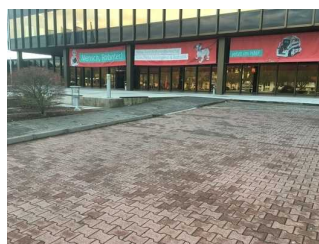
Weg außen (Parkplatz - Eingang)
