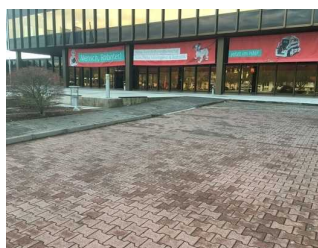
Weg außen (Parkplatz - Eingang)
